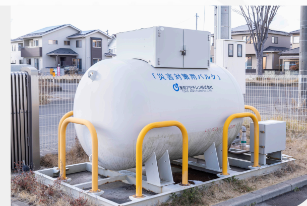
災害時においても施設の機能を維持できる「LP ガス災害バルク」
