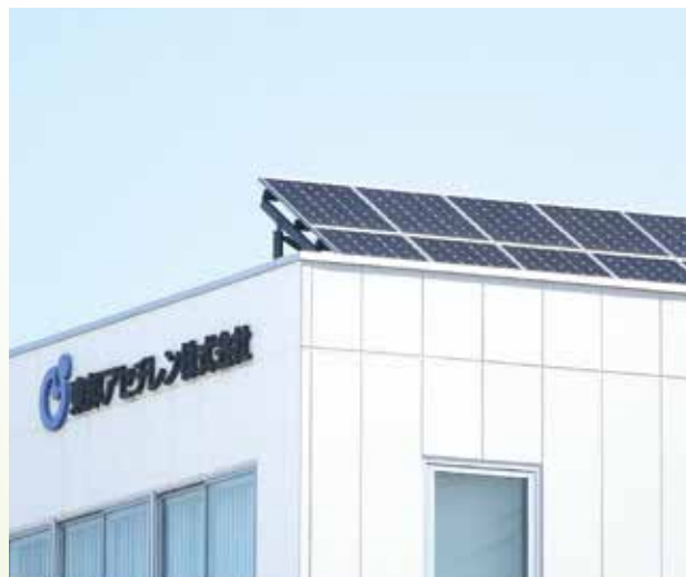
本社設置太陽光パネル
